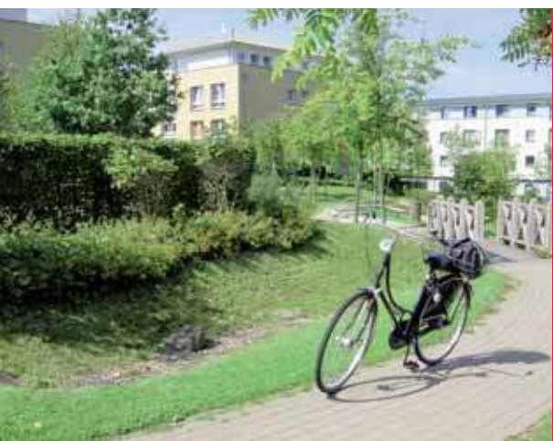
Mulden-Rigole im privaten Bereich Hollow-trench in a private area
