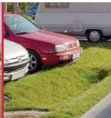
Entwässerung im Straßenraum Roadside drainage
