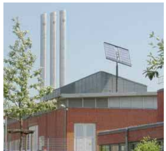
Energiezentrale (BHKW) im Süd Southern energy centre (decentral CHP plant)
