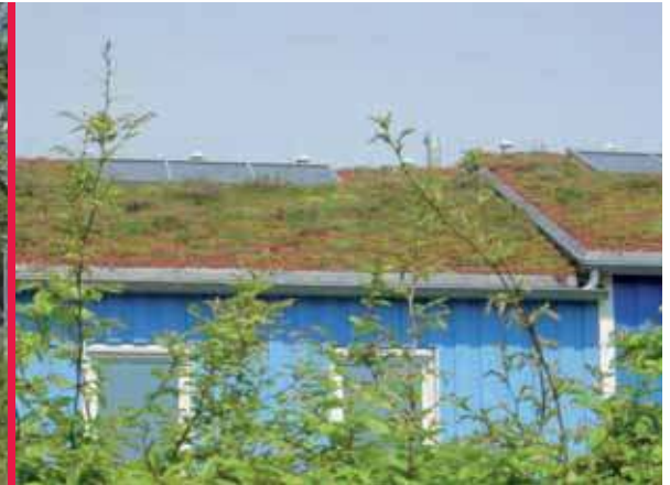
Dachbegrünung mit Solarkollektoren Roof greening with solar thermal collectors
