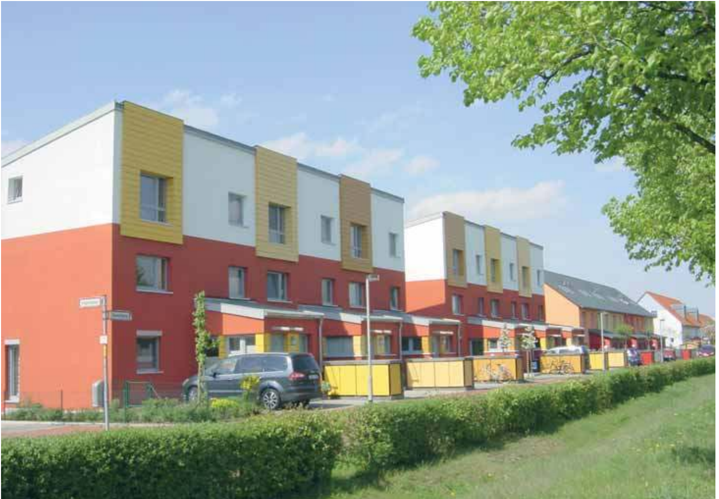
Reihenhäuser am östlichen Siedlungsrand | Terraced houses on the eastern edge of the development
