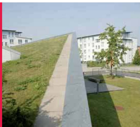
Dachbegrünung Roof greening
